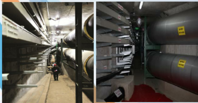
月亮湾综合管廊内部实景
